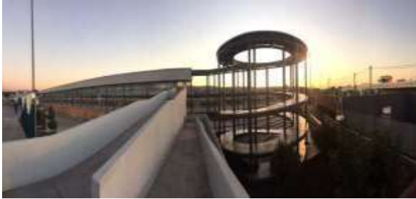
Nuevas instalaciones peatonales “Acceso Peatonal Oeste” en El Chaparral-San Ysidro.
